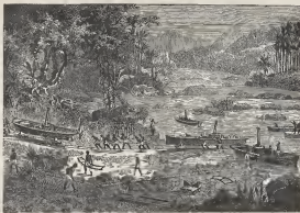
DÉBALLAGE DE CHÈVRES DE FER DECAUVILLE ET CHARGEMENT DES CHEVROTES SUR LES WAGONS, dans l'opération de l'Oploos lorsque les stations exploitées cessent d'être navigables
